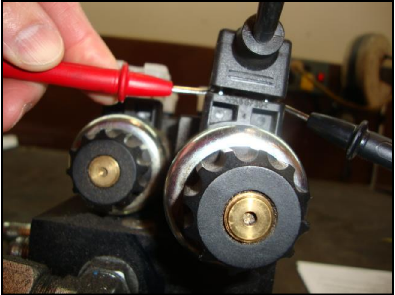
Figure 8-4 Checking Din Plug Voltage
